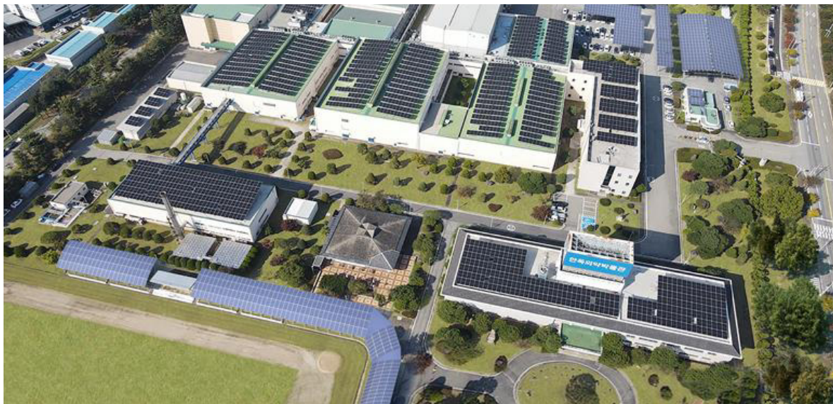
한독캠퍼스 태양광 발전 전경
